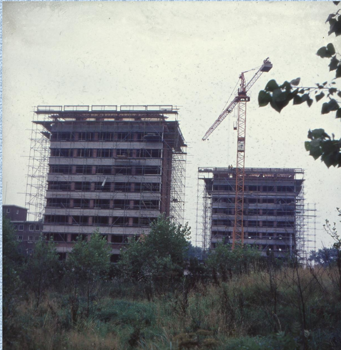
De zusterhuizen in aanbouw
