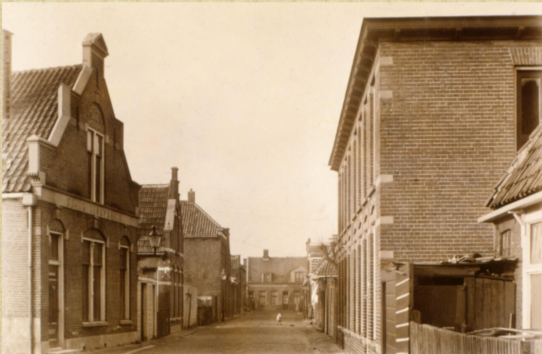
Links het eerste ziekenhuis in de Havenstraat (1919)
