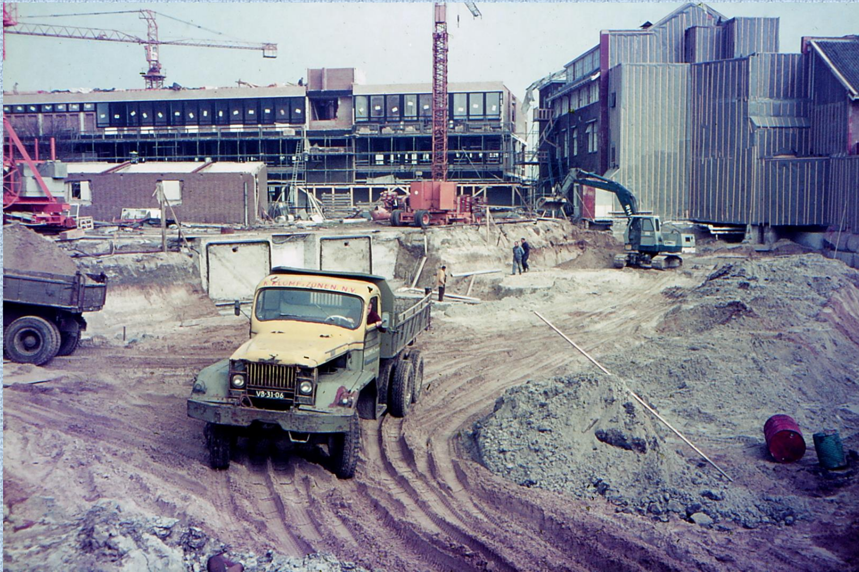
Uitgraven van de bouwput
